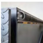
JUNTA DE ESTANQUEIDAD DE RAMPA
